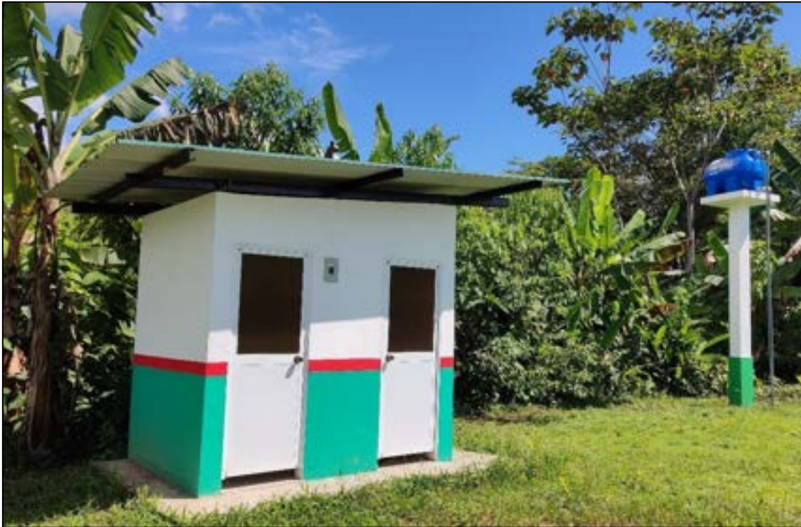
Fotografía N° 25. Infraestructura de saneamiento
