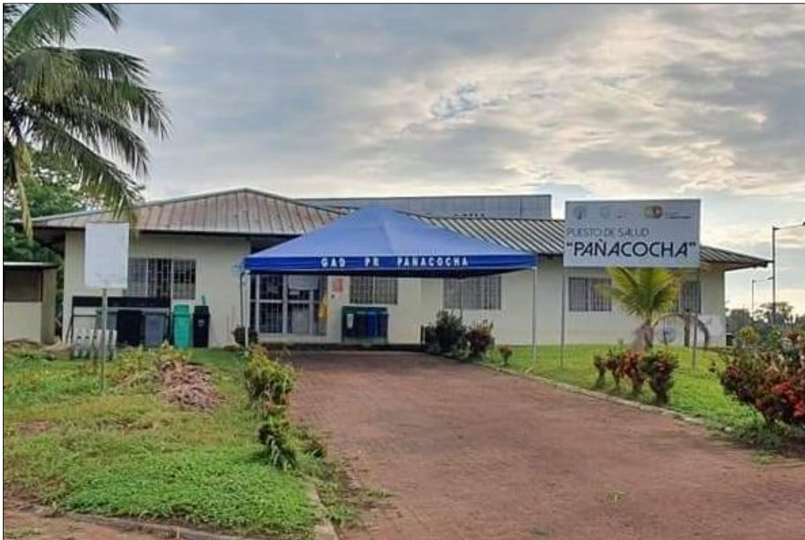
Fotografía N° 19. Puesto de salud
