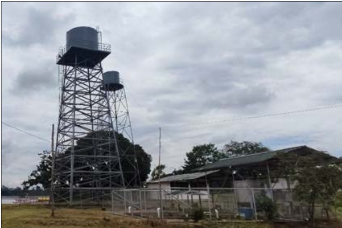
Fotografía N° 24. Infraestructura de agua
