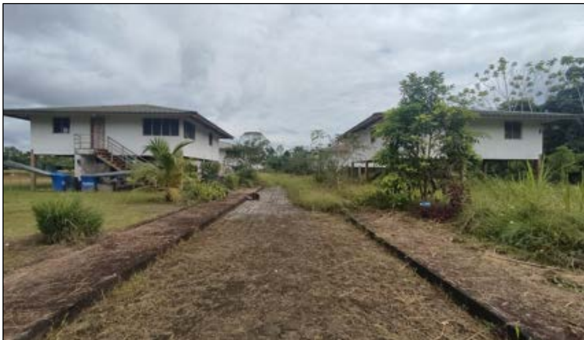
Fotografía N° 26. Infraestructura de vivienda
